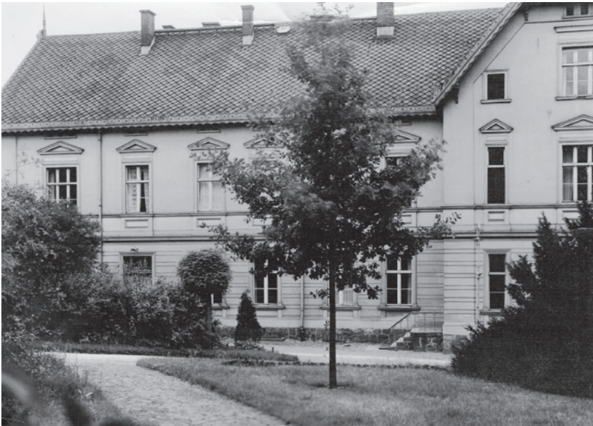
Haus 5 der Kückenmühler Anstalten
